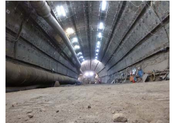
Aktueller Ausbau im Füllort 2. Sohle
