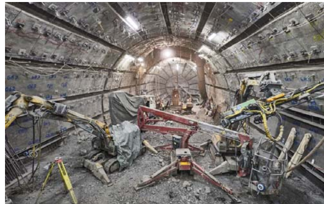
Aktueller Ausbau im Füllort 2. Sohle
